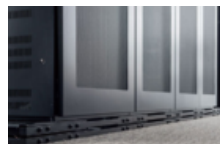
サーバーラック・配線の撤去など幅広く対応
