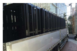
サーバラック 撤去
