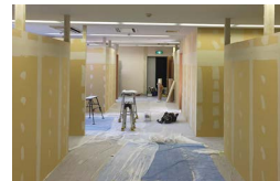
間仕切り工事
