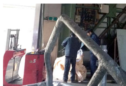
配管も撤去し、 原状回復工事
