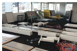
解体された 什器類
