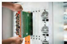
ネットワーク機器 を撤去・移送・移設
