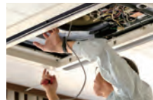
エアコンの 撤去工事
