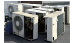
貯水タンクと室外機 撤去工事
