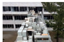
渡り通路から 地上に荷卸し
