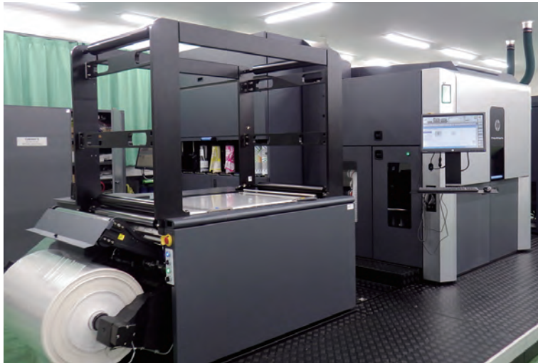
印刷機を溶断バーナーで解体 エアコンや貯水タンクも撤去
