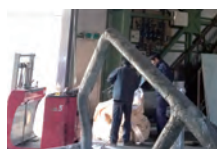
配管も撤去し、 原状回復工事
