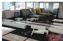
解体された 什器類
