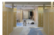
間仕切り工事
